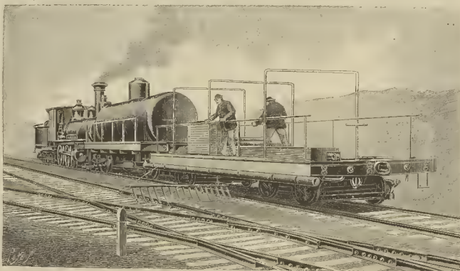
Aparato Nichol para el riego de las vías férreas
